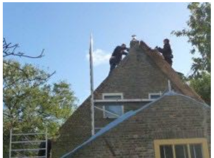
Nieuw riet op het dak!
