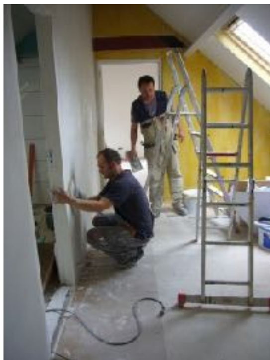
Werkzaamheden op de overloop
