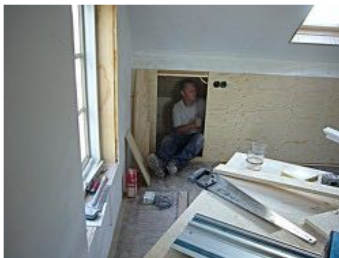
Pepijn in de kast van de technische ruimte
